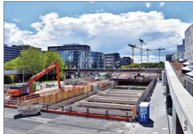
U-Bahn-Bau in Hamburg – ab Seite 22
