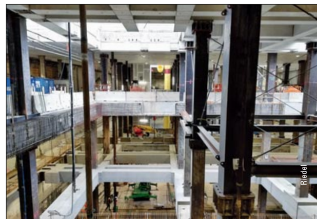
Schnellbahnbau u. -modernisierung in München – ab S. 44
