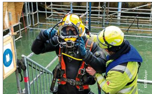
Kölner Nord-Süd-Stadtbahn: Sanierung der Havariestelle, ab S. 14
