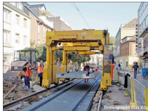
Firmengruppe Max Bögl Oberbauanierung und Gleisbau in Frechen – ab Seite 11
